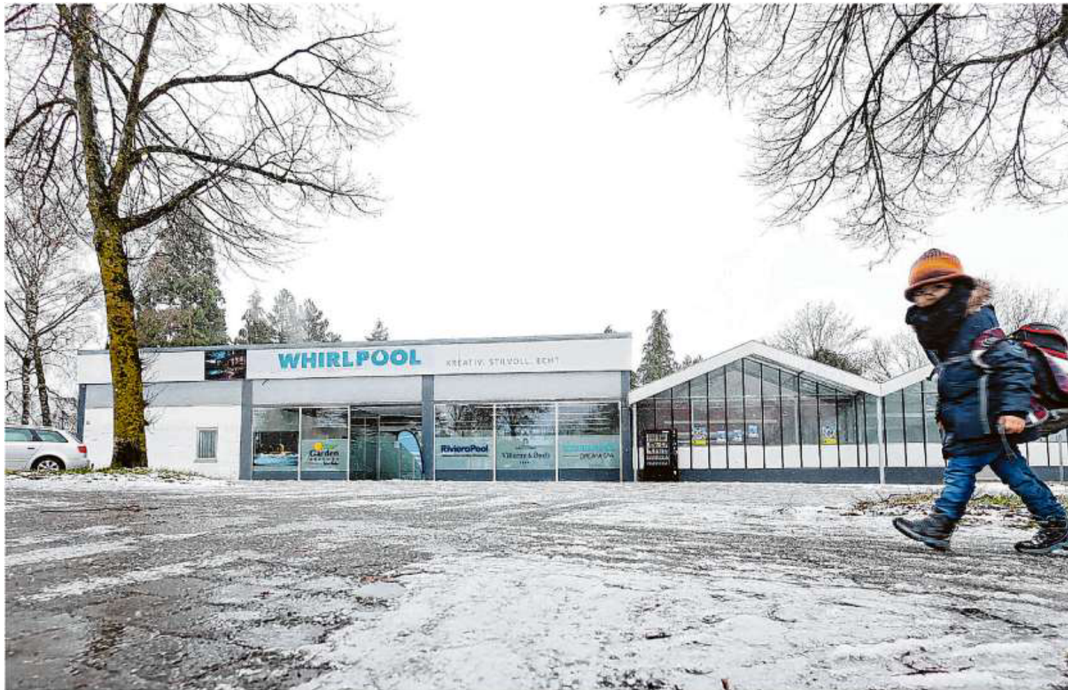
Der ehemalige Haller Gartentreff dient aktuell als Showroom der Firma Whirlpool.
